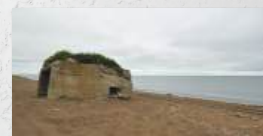
Японский дот на Сахалине. Современный вид.
